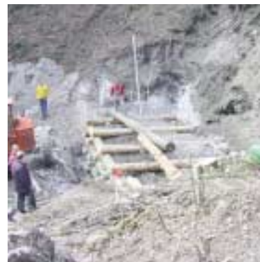
Frana: inizi dell'intervento di messa in sicurezza
