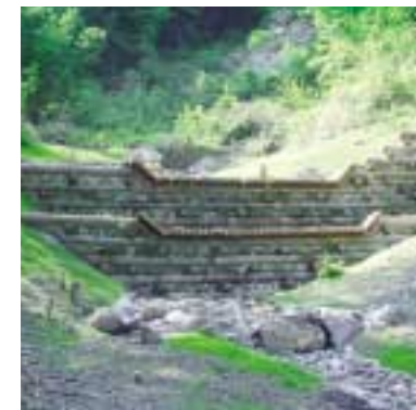
Situazione a conclusione dell'intervento di messa in sicurezza
